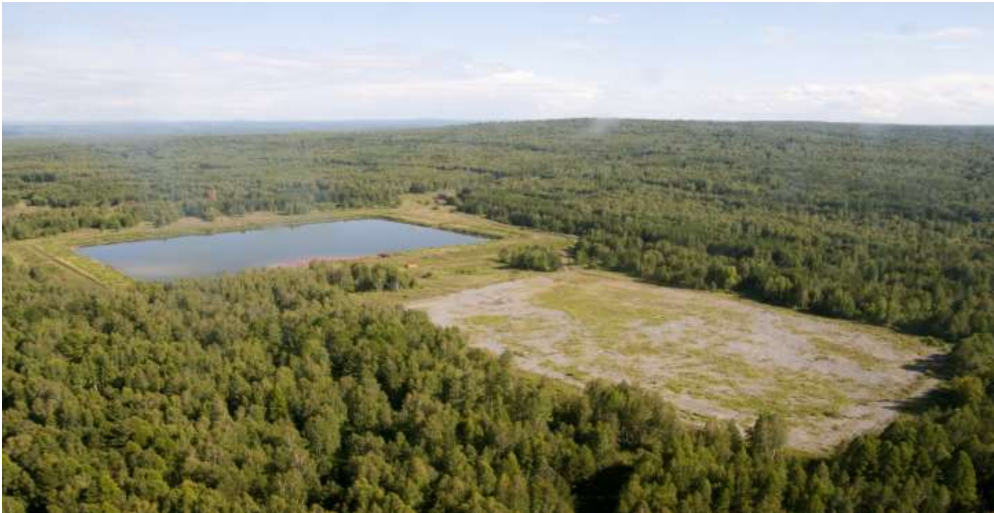
Бассейн (справа) после завершения работ по ВЭ
