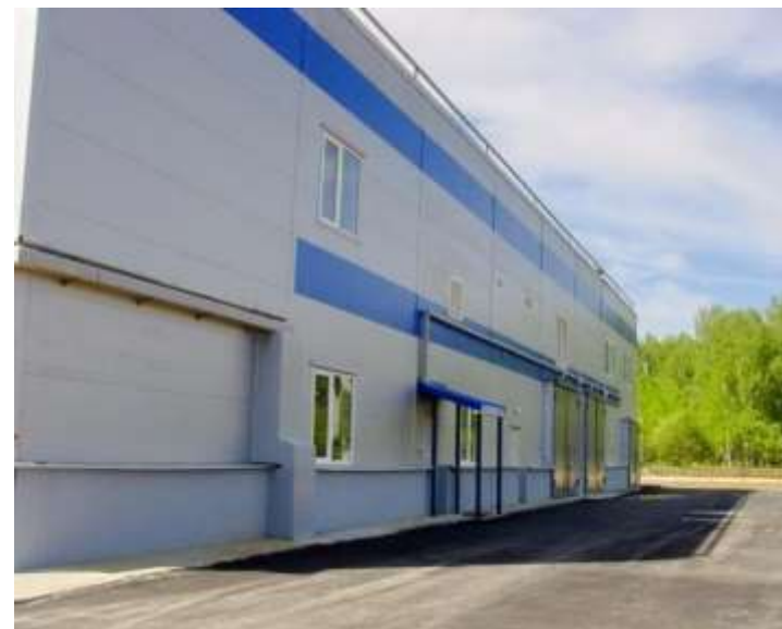
Производственный корпус зд.44
