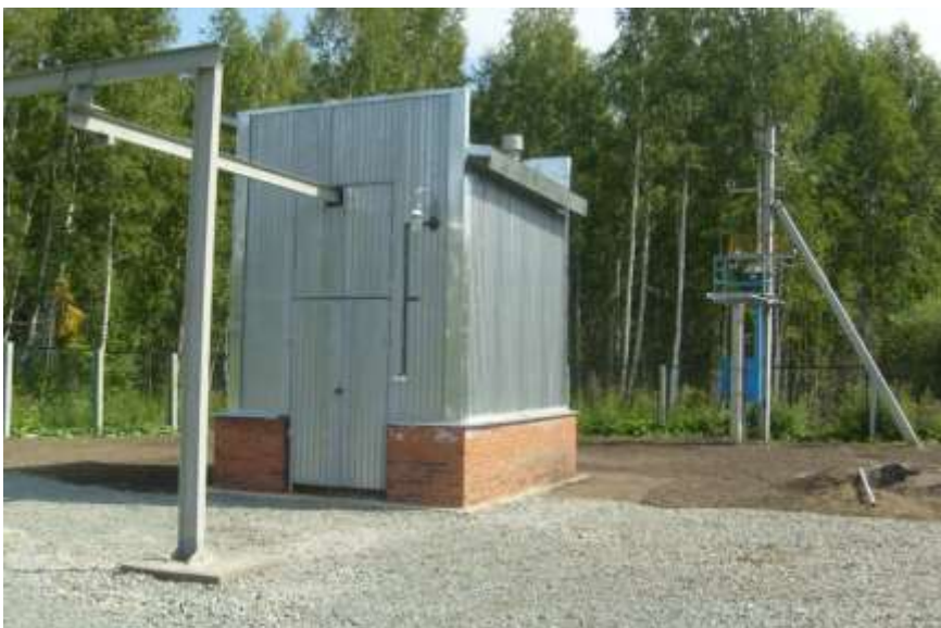
Насосная станция зд.653
