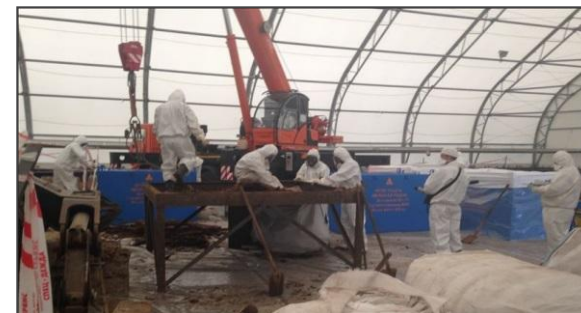
Вывод хранилища РАО из эксплуатации
