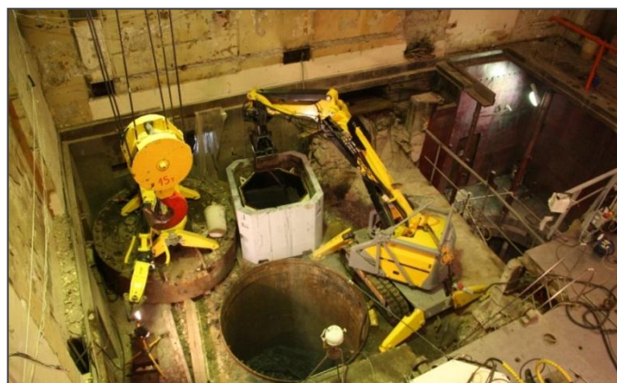
Демонтаж графитовой кладки реактора
