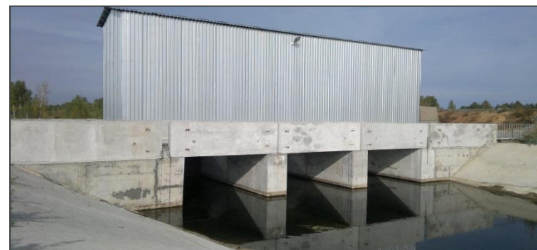
Созданы пороги-регуляторы для исключения попадания загрязнённой воды в открытую гидросеть
