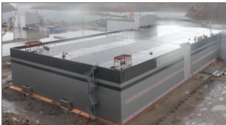
Центр по хранению и переработке РАО в Северо-Западном регионе
