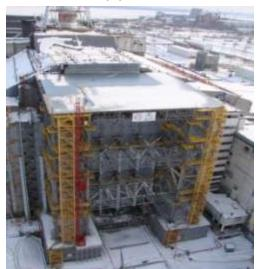
Монтаж экранов и металлоконструкций сопряжения
